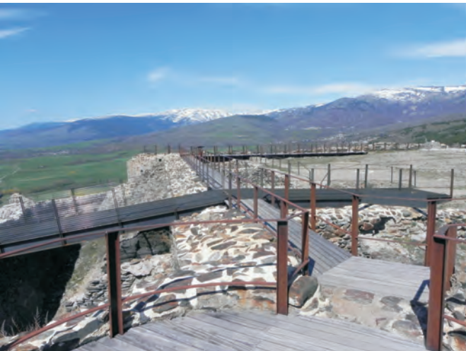
Vista del pont i de la intervenció
