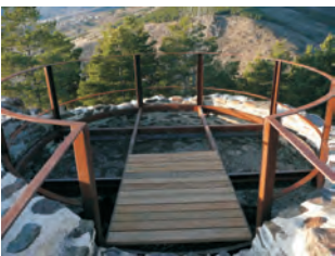
Adequació de la torre nord-oest
