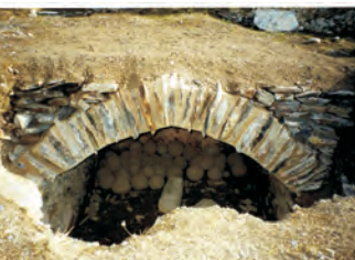
Cisterna de la torre de l'homenatge
