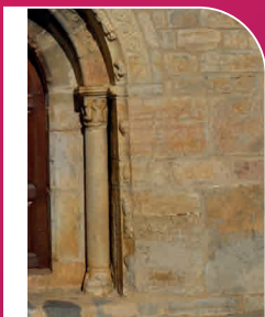
Detall dels grans carreus de la façana de l'església de Santa Maria d'All, presumptament reutilitzats d'antigues construccions romanes.
