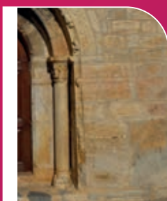
Détail des grandes pierres de taille de la façade de l'église de Santa Maria d'All, supposément réutilisées des constructions romaines antiques.
