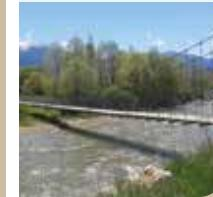
La Palanca de la rivière Segre est une passerelle, autrefois construite en rondins par les habitants des villages d'All et de Sanavastre, afin d'avoir un passage sur la Segre. Il est actuellement constitué de câbles et de vis en fer.
